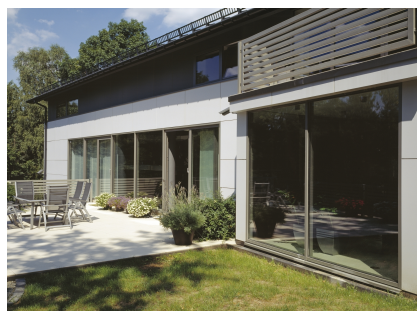
Fot. Przykład budynku energooszczędnego Willa w Olkuszu (© Pilkington Polska)
