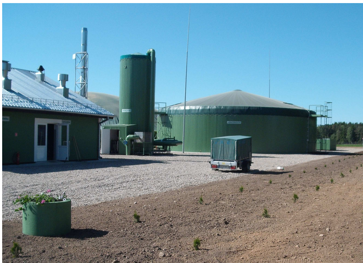
Fotografia 5 Widok biogazowni w Naclawiu.
