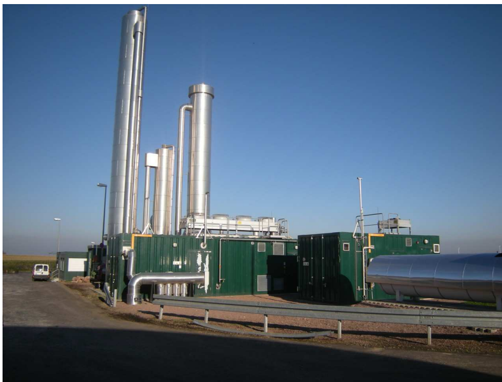
Fotografia 2 Przykładowa instalacja do oczyszczania biogazu do jakości gazu ziemnego. (archiwum IEO)
