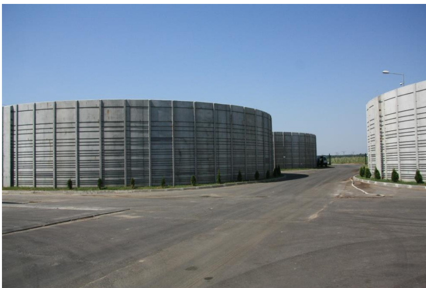
Ryc. 25 Zbiorniki na płynną masę pofermentacyjną, biogazownia nr 2
