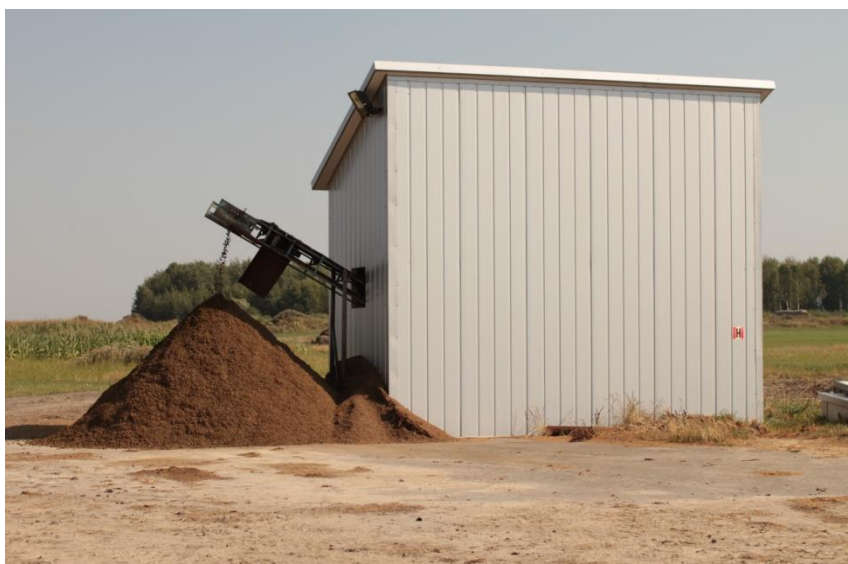
Ryc. 16 Stacja rozdziału faz masy pofermentacyjnej, biogazownia nr 1
