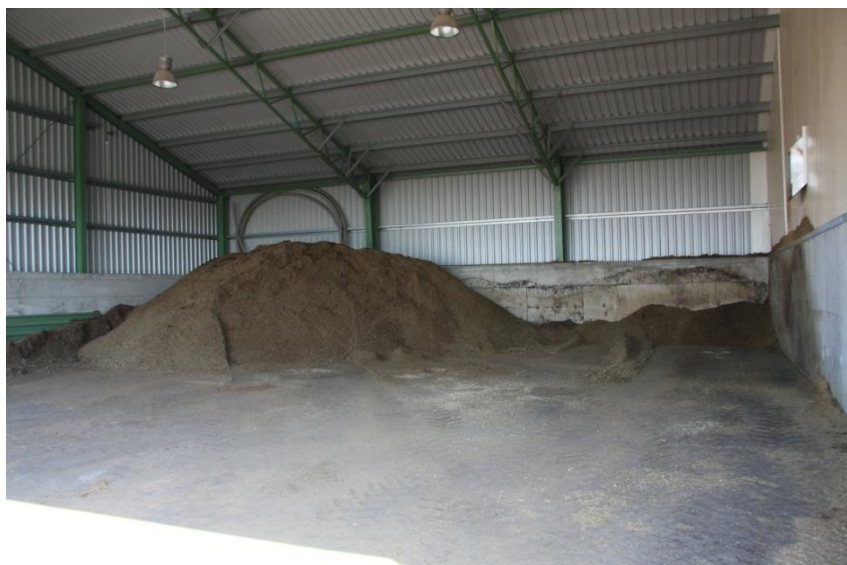
Ryc. 24 Magazyn frakcji stałej masy pofermentacyjnej, biogazownia nr 2
