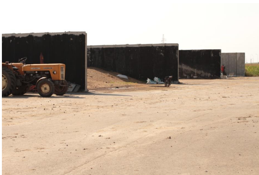
Ryc. 14 Silosy przejazdowe do przechowywania kiszonki traw, biogazownia nr 1
