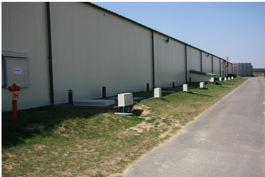
Ryc. 22 Komora fermentacji, biogazownia nr 2
