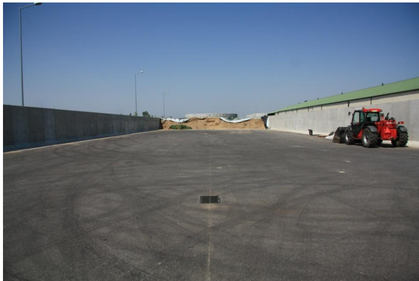
Ryc. 21 Silosy do przechowywania substratów stałych, biogazownia nr 2
