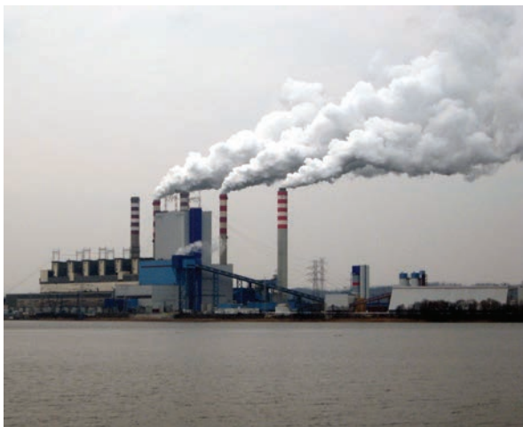
PĄTNÓW POWER PLANT. © Tomasz Krzykała
