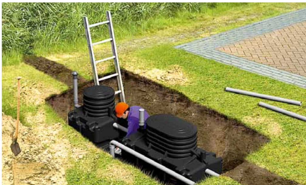
Montaż oczyszczalni przydomowej
