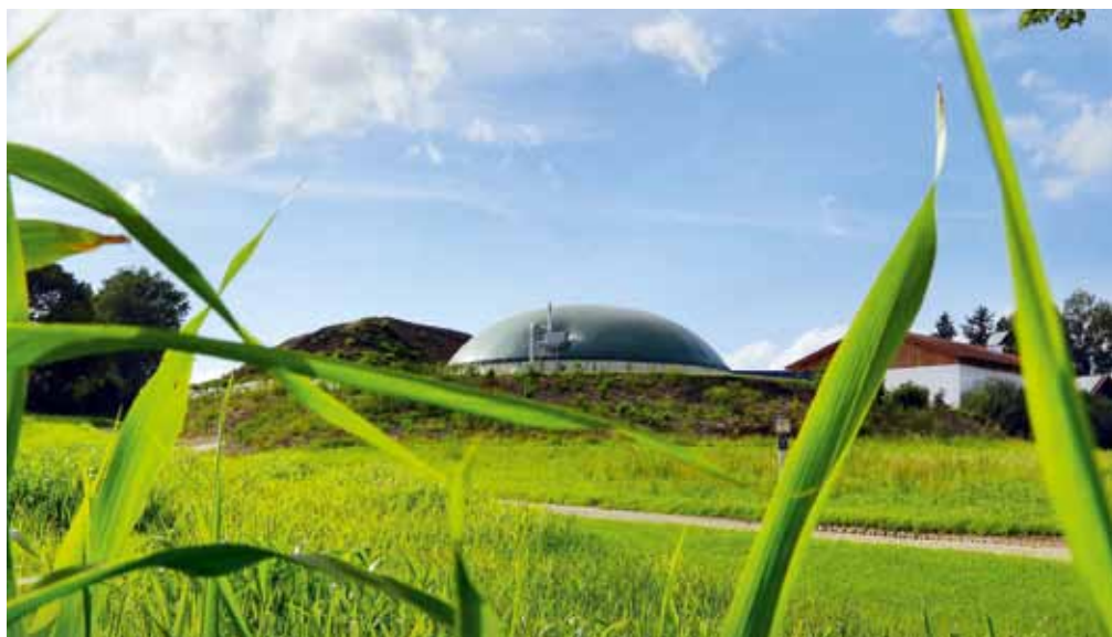
Mała biogazownia rolnicza
