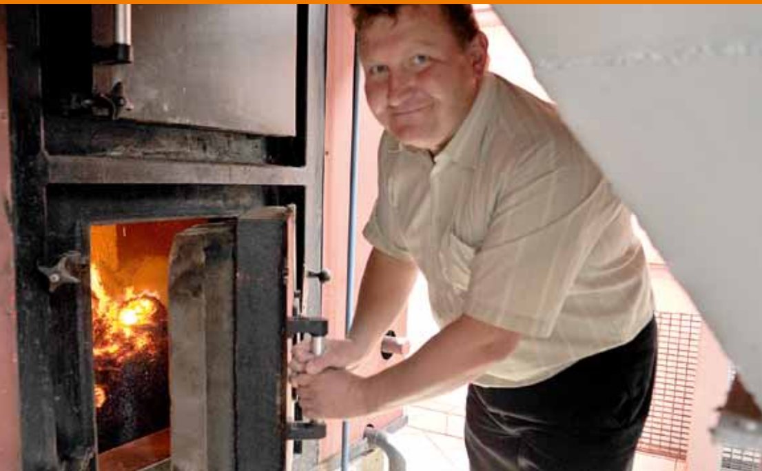
Ryc. 13. Kisielice, Pan Sławomir Dąbrowski w miejskiej kotłowni na biomasę.
