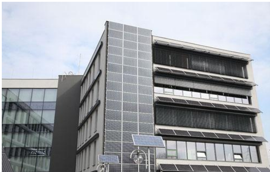
Zewnętrzne żaluzje oraz panele fotowoltaiczne umieszczone na fasadzie budynku i w pasach międzyokiennej (fot. Euro-Centrum Park Naukowo-Technologiczny)
