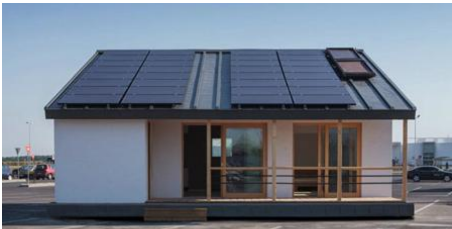
Kolektory słoneczne i panele fotowoltaiczne zamontowane na dachu (źródło: www.prispa.org )
