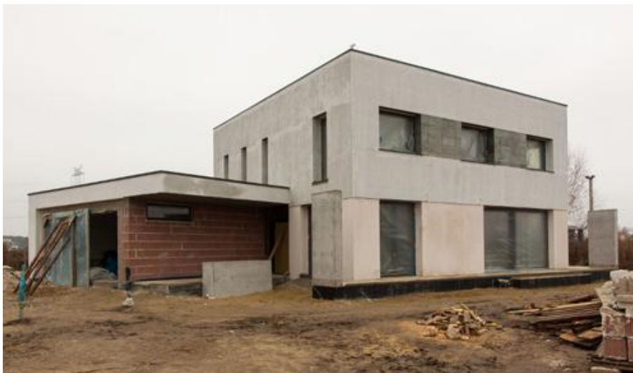
Budowa na etapie wykańczania elewacji (źródło: www.budujzkape.pl )
