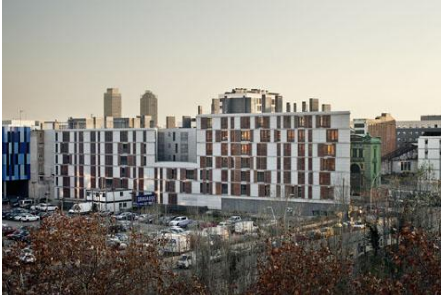
Energooszczędny budynek w Barcelonie (źródło: PMHB, fot. Jordi Surroca)
