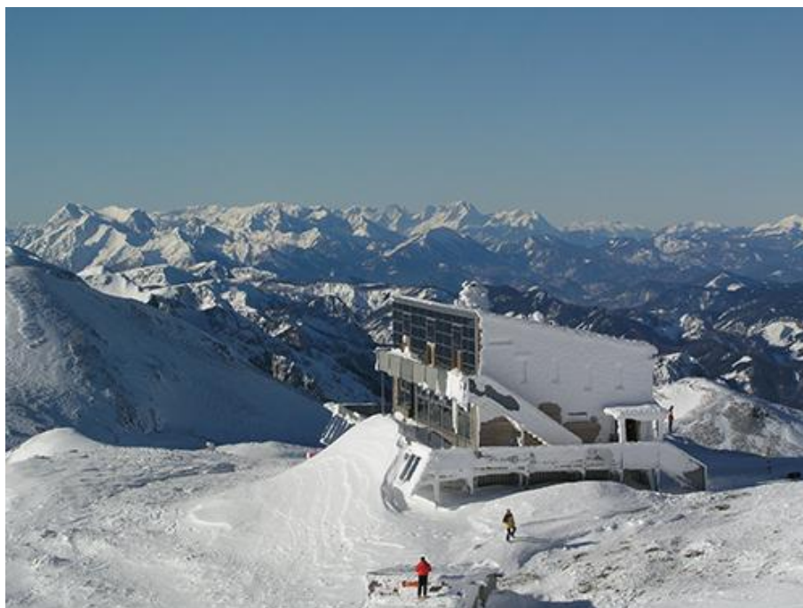
Odporny na ekstremalne warunki pogodowe budynek górskiego schroniska (źródło: ÖTK)
