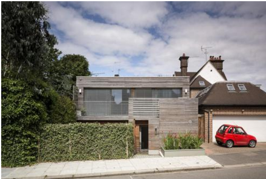
Pasywny budynek od strony ulicy (źródło: bere:architects, fot. Tim Crocker)
