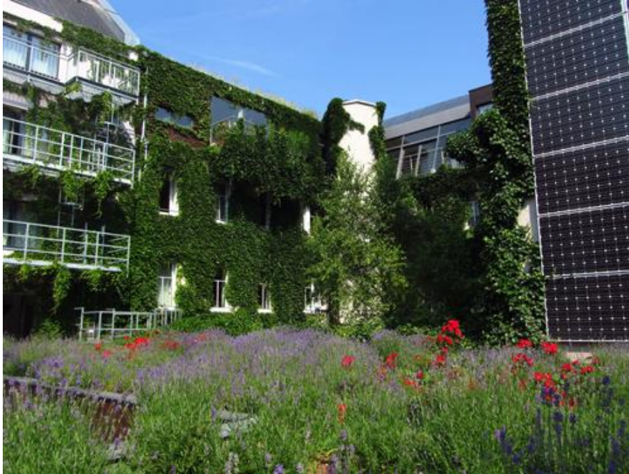
Panele fotowoltaiczne na południowej elewacji (źródło: www.hotelstadthalle.at )
