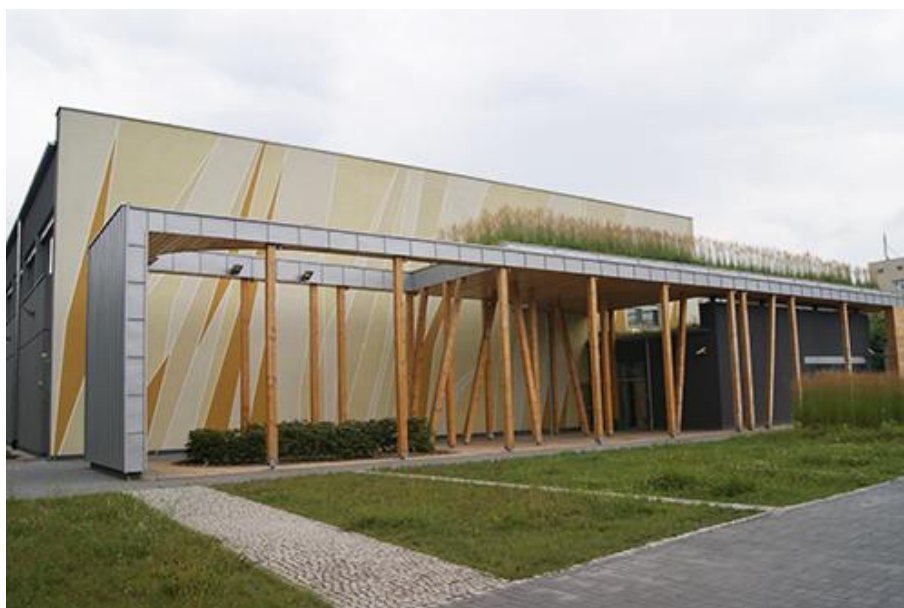
Budynek hali (fot. ChronmyKlimat.pl )
