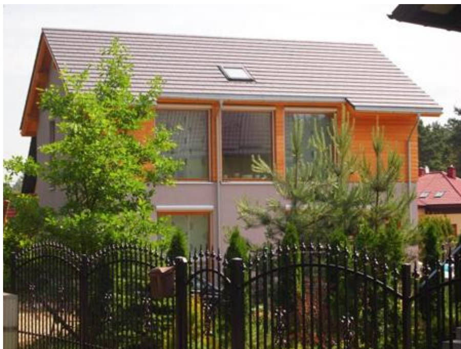
Cofnięta krawędź dachu i okna wyposażone w zewnętrzne rolety (fot. MultiComfort)
