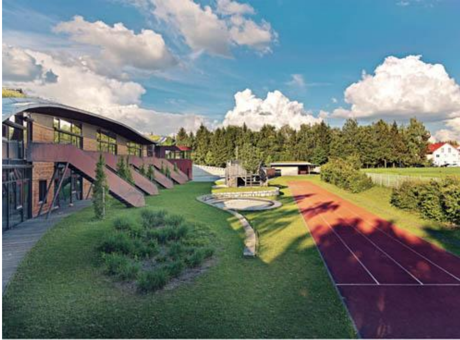
Zewnętrzne schody prowadzące do sal na piętrze (fot. Jakob Kanzleiter, www.jacobkanzleiter.com )
