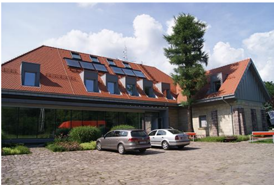
Budynek laboratorium po przebudowie (fot. ChronmyKlimat.pl)
