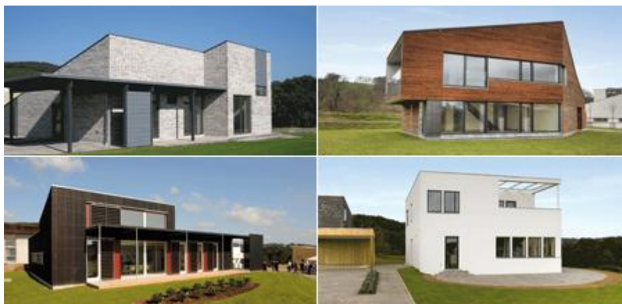
Domy wybudowane w ramach inwestycji „Komfort Husene” (źródło: www.komforthusene.dk )
