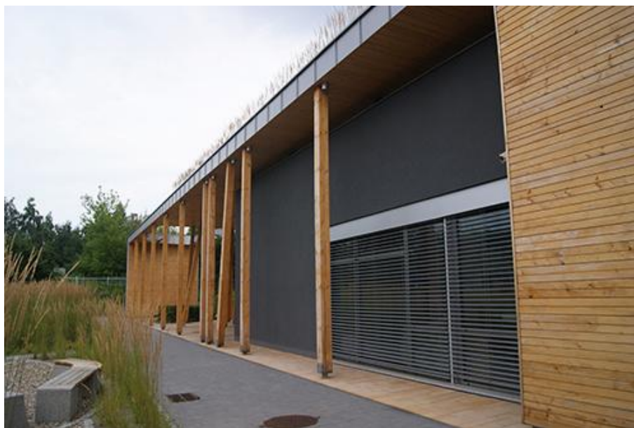
Zacieniające żaluzje (fot. ChronmyKlimat.pl)
