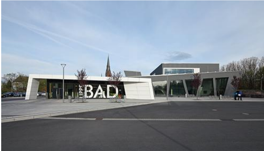
Budynek pływalni „Lippe-Bad” (źródło: nps tchoban voss)
