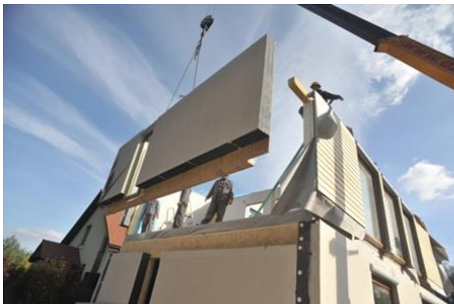
Budowa domu z prefabrykowanych elementów (źródło: MultiComfort)
