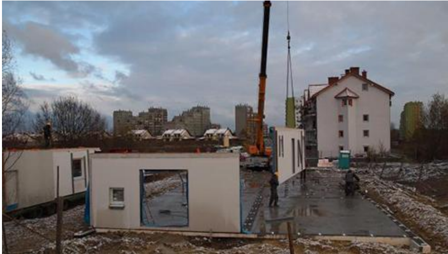
Budowa przedszkola z prefabrykowanych elementów (źródło: MultiComfort)
