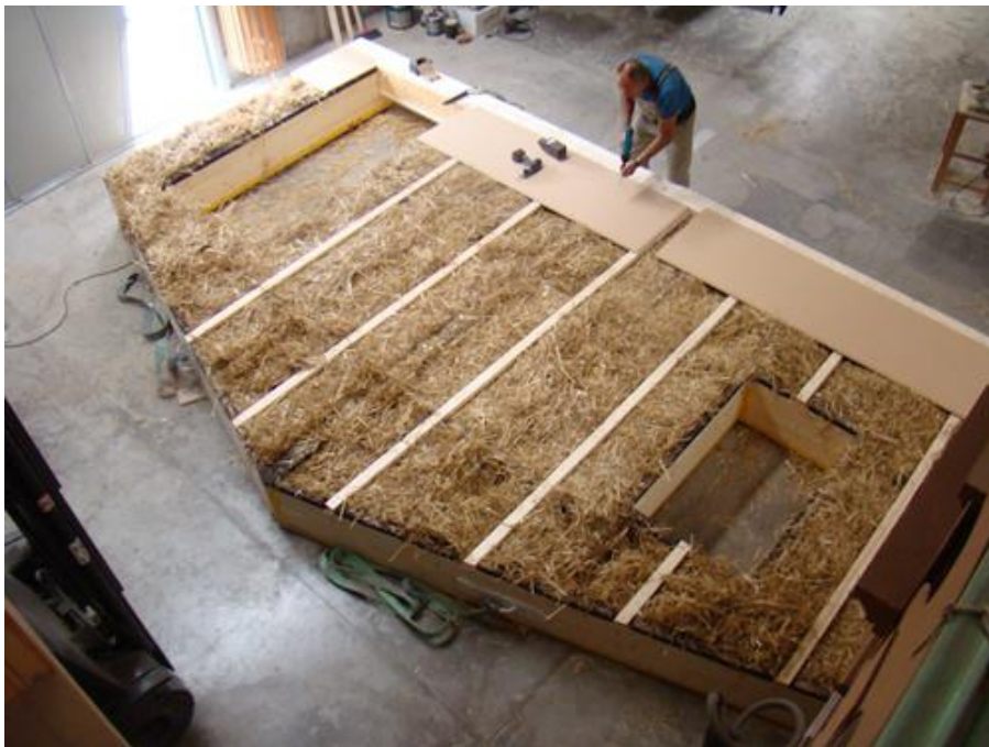
Technologia budowy w oparciu o drewno i słomę (fot. www.larixhaus.cat )
