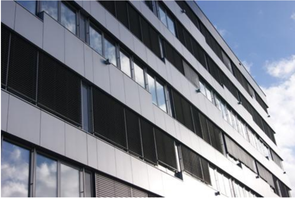
System automatycznie sterowanych żaluzji zewnętrznych (fot. ChronmyKlimat.pl)
