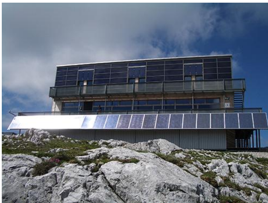
Kolektory słoneczne i ogniwa fotowoltaiczne zamontowane na budynku (źródło: Pos architekten)
