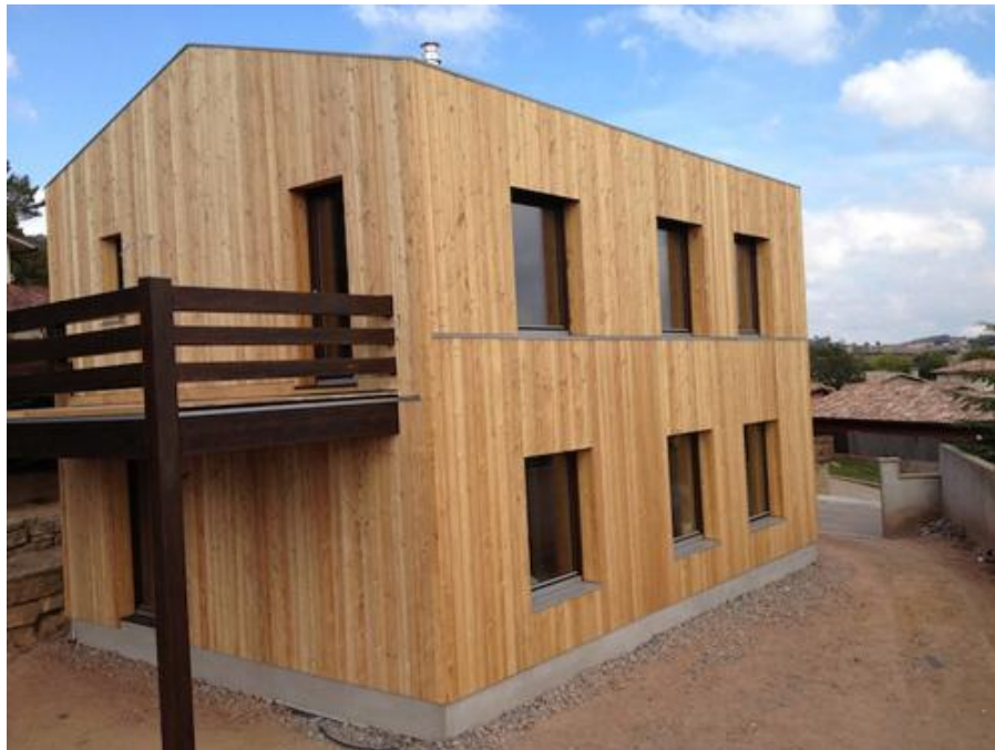
Drewniana obudowa budynku (fot. www.larixhaus.cat )
