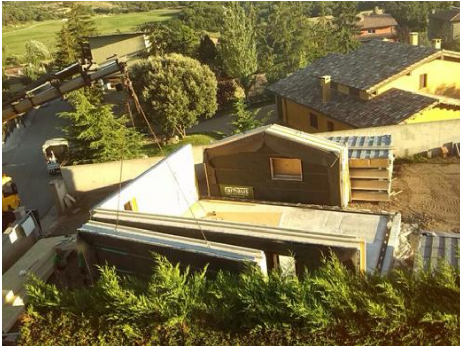
Budowa domu „Larixhaus” (fot. www.larixhaus.cat )
