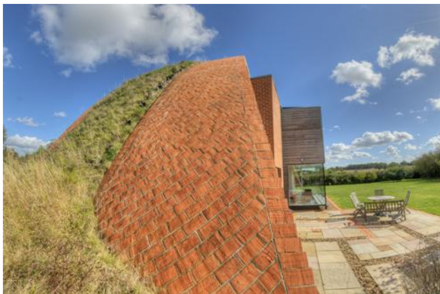
Łukowe sklepienie wykonane z lokalnie produkowanych materiałów (źródło: Hawkes Architecture)
