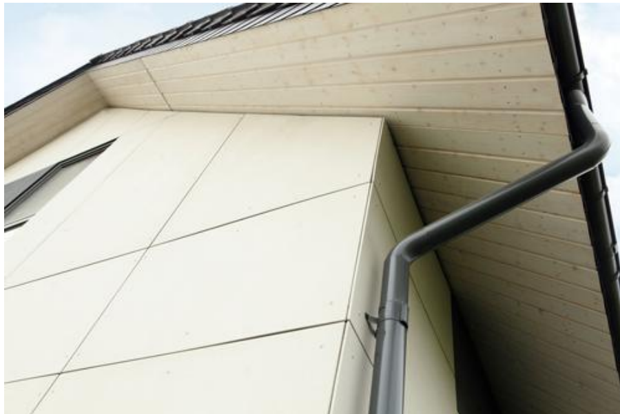
Elewacja wykonana z płyt włókno-cementowych (fot. Procyon)
