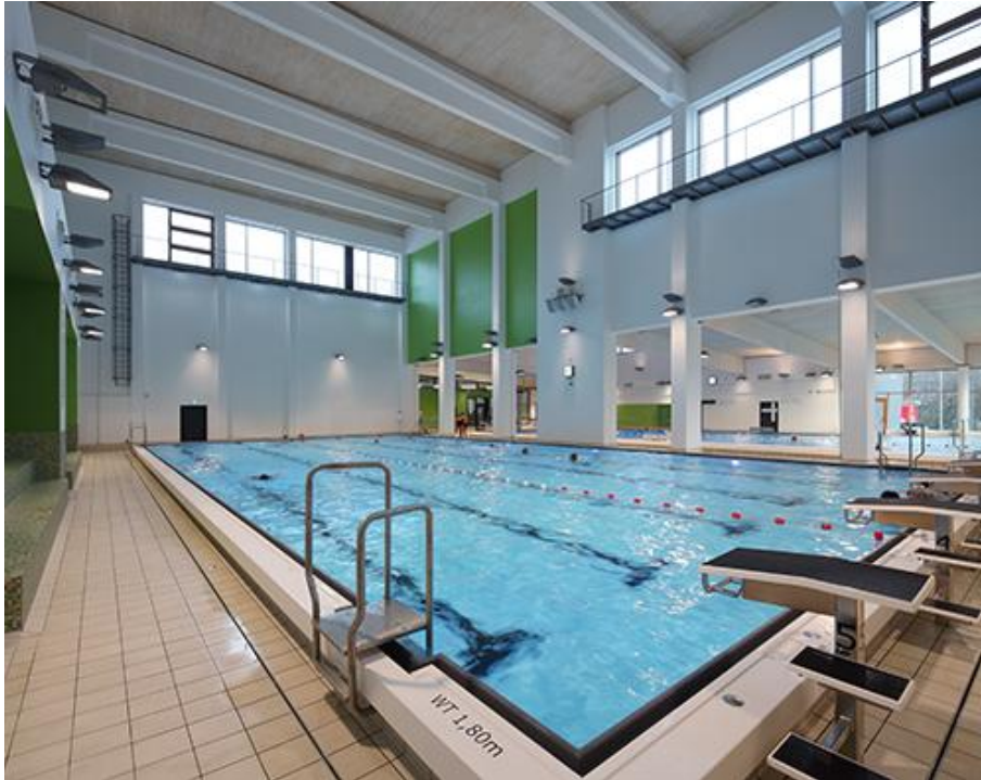
Baseny pływackie w pasywnym budynku (źródło: nps tchoban voss)
