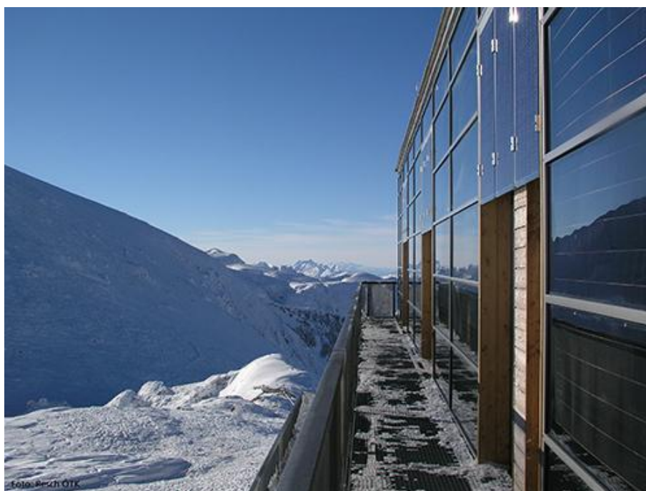
Przeszklenia od strony południowej (źródło: Pos architekten)
