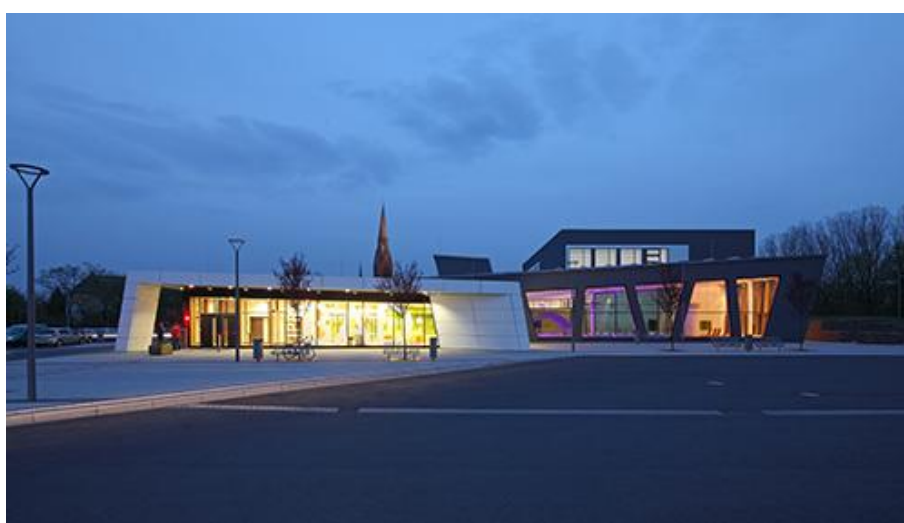
Energooszczędne oświetlenie pływalni (źródło: nps tchoban voss)
