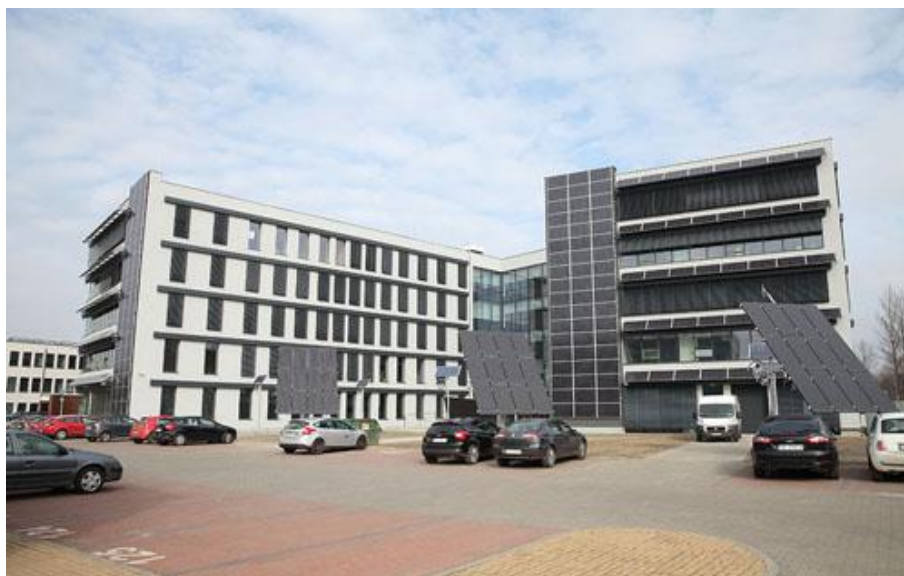
Ruchome moduły fotowoltaiczne (fot. Euro-Centrum Park Naukowo-Technologiczny)
