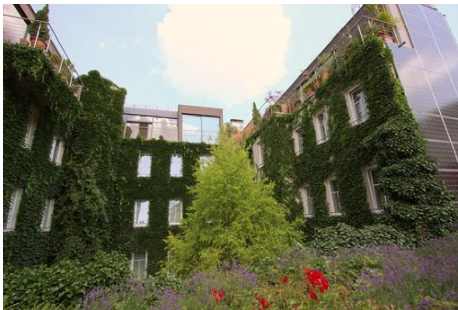
Porośnięte roślinnością ściany budynku (źródło: www.hotelstadthalle.at )
