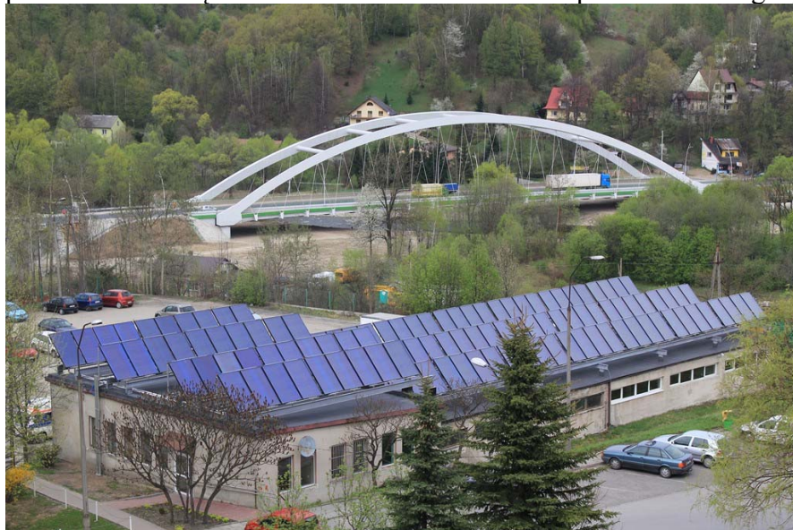
Zdjęcie 1 Kolektory słoneczne na budynku szpitala w Suchej Beskidzkiej
