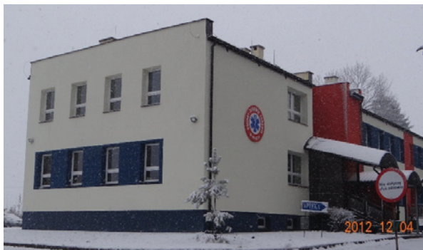
Foto 9.1: Elewacja ośrodka zdrowia po termomodernizacji; źródło: http://www.mircze.pl
