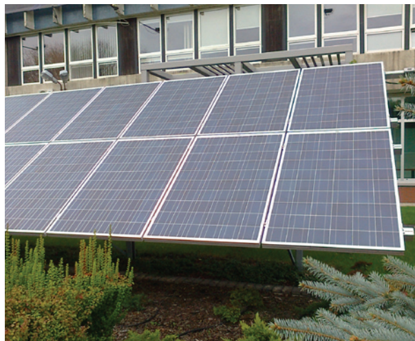
Foto 10.2. Instalacja PV nieruchoma konstrukcja wolnostojąca
