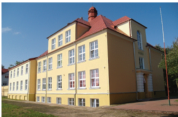
Foto 9.2: Jeden z budynków po termomodernizacji; źródło: http://www.nasielsk.pl
